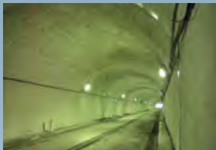
Ute Túnel de Bielsa Impermeabilización de superficie
