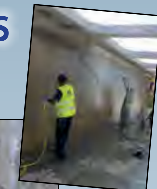
ANTICARBONATION TREATMENT OF WALLS ORTIZ. Depósitos CYII (El Pardo)
