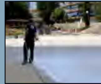
ROOFING Fatecsa Obras, Aparcamiento Subterráneo. c/ Montecarlo (4.000 m 2 )
