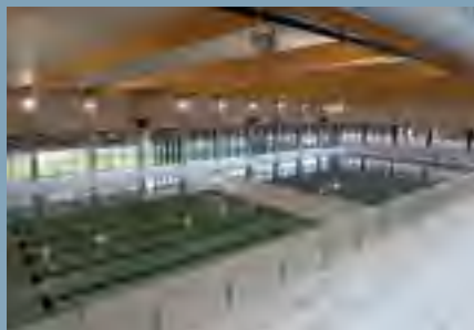
Instalaciones Deportivas Coslada UTE. Madrid Impermeabilización de playas, piscinas y spa Superficie a tratar 8.000 m 2
