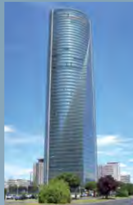
OHL - Obra Torre Espacio (Madrid) Impermeabilización zonas húmedas y aljibes
