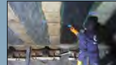
CONCRETE SLABS Supermercados Madrid - Las Rozas
