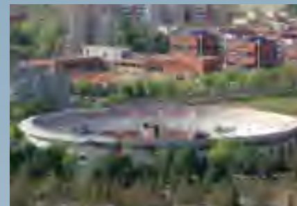
Sacyr - Coso Polivalente de Puertollano Sellado de juntas 7.500 m
