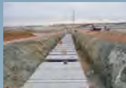
Sacyr - Colector Ámbito M-45. Madrid Sellado de juntas 100.000 m
